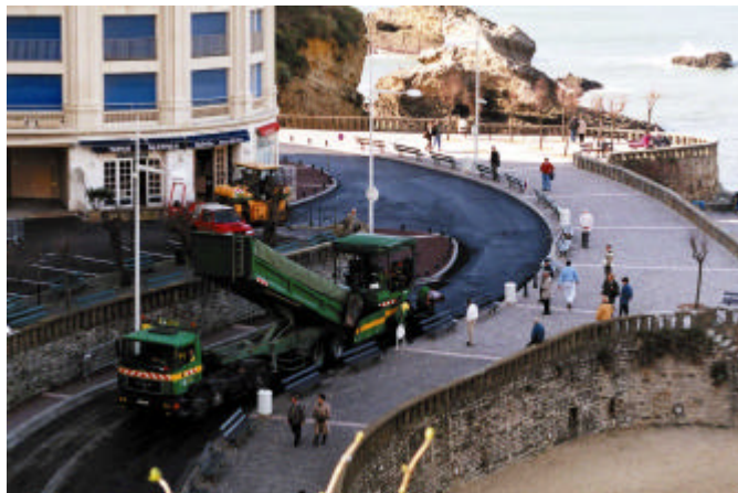
Mise en œuvre de Scintiflex
