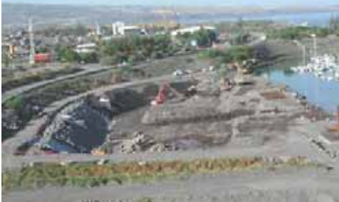
Extension des bassins – Le Port – (F-Ile de La Réunion) - 2001
