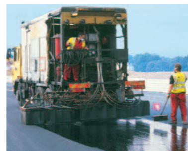
Application du liant
